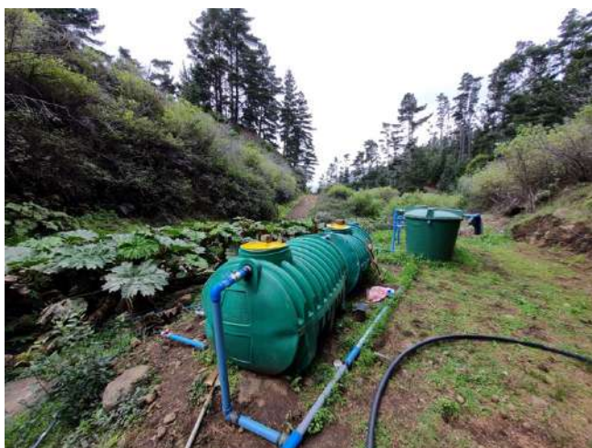
Fotografía 8 Instalaciones de agua para consumo doméstico. Captación La Pólvora.
