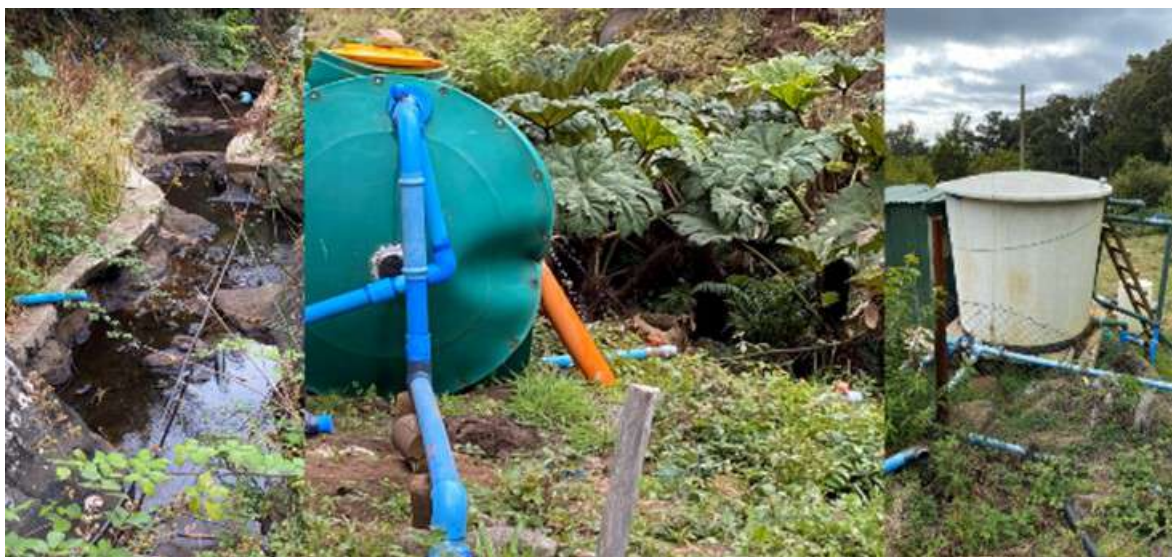
Imagen 27 Toma y almacenamiento utilizando una fosa sanitaria y área de cloración de agua domiciliaria
