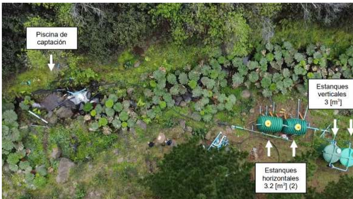
Imagen 28 Vista aérea toma de agua
