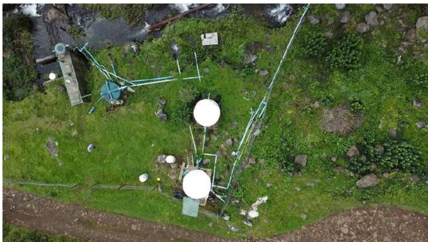
Fotografía 7 Instalaciones de agua para consumo doméstico. Captación Lord Anson.
